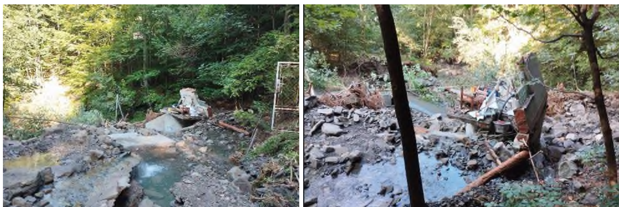
Obr. 12, 13: Jímání vody s troskami objektu čerpací stanice na vodním toku Satiny v říčním kilometru 5,7. Stav bezprostředně po povodni v září 2024.
