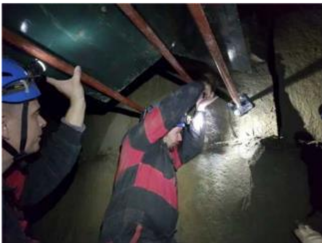
Obrázek 3: Instalace ochrany terčového měřidla
