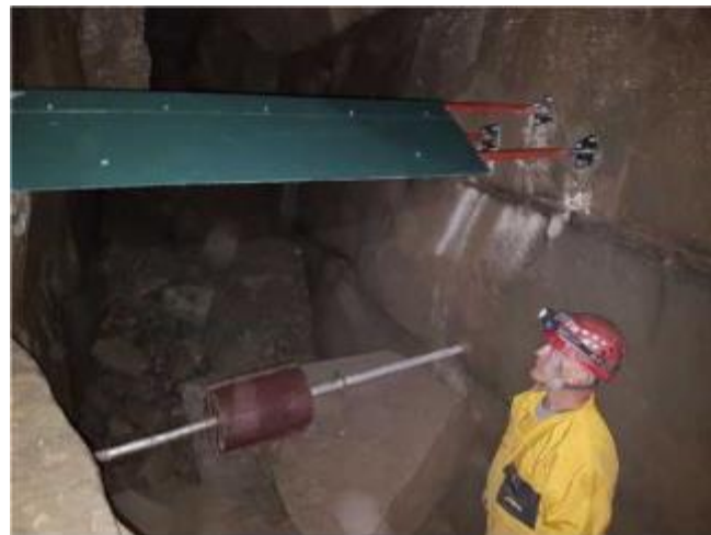
Obrázek 4: Instalace ochrany terčového měřidla
