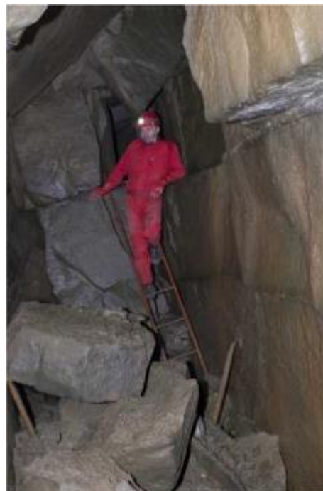
Obrázek 1: Stav v Komoře po spadu skalních bloků v roce 2017
