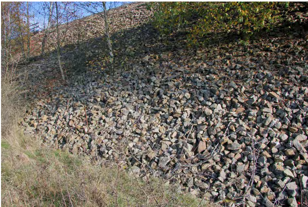
Obr. 9. Železniční násep podél jihovýchodní hranice ZCHÚ po rozšíření základny při rekonstrukci železničního úseku Zbiroh-Rokycany.
