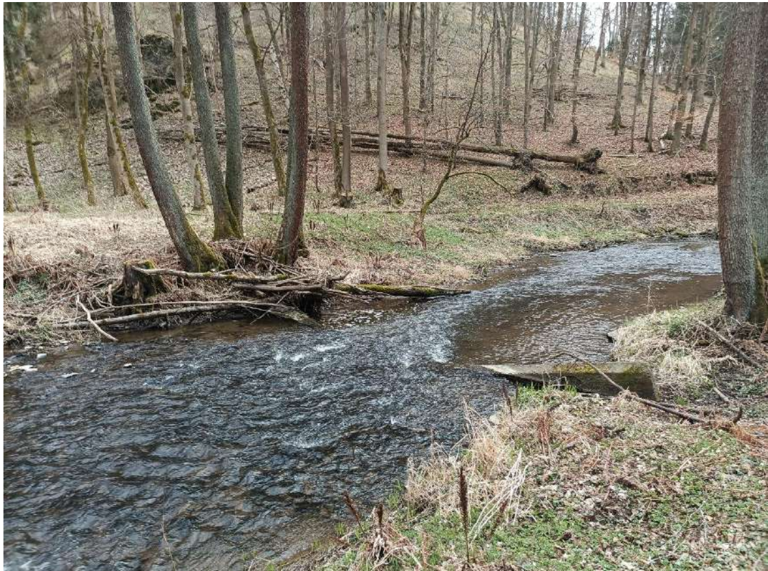
Zbytky betonového příčného prahu
