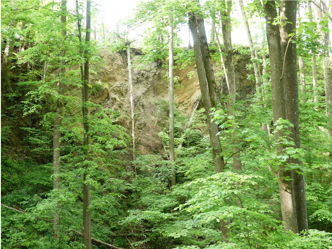
Svahový sesuv v severozápadní části lomové jámy – 14. 5. 2025 (foto M. Dýma)
