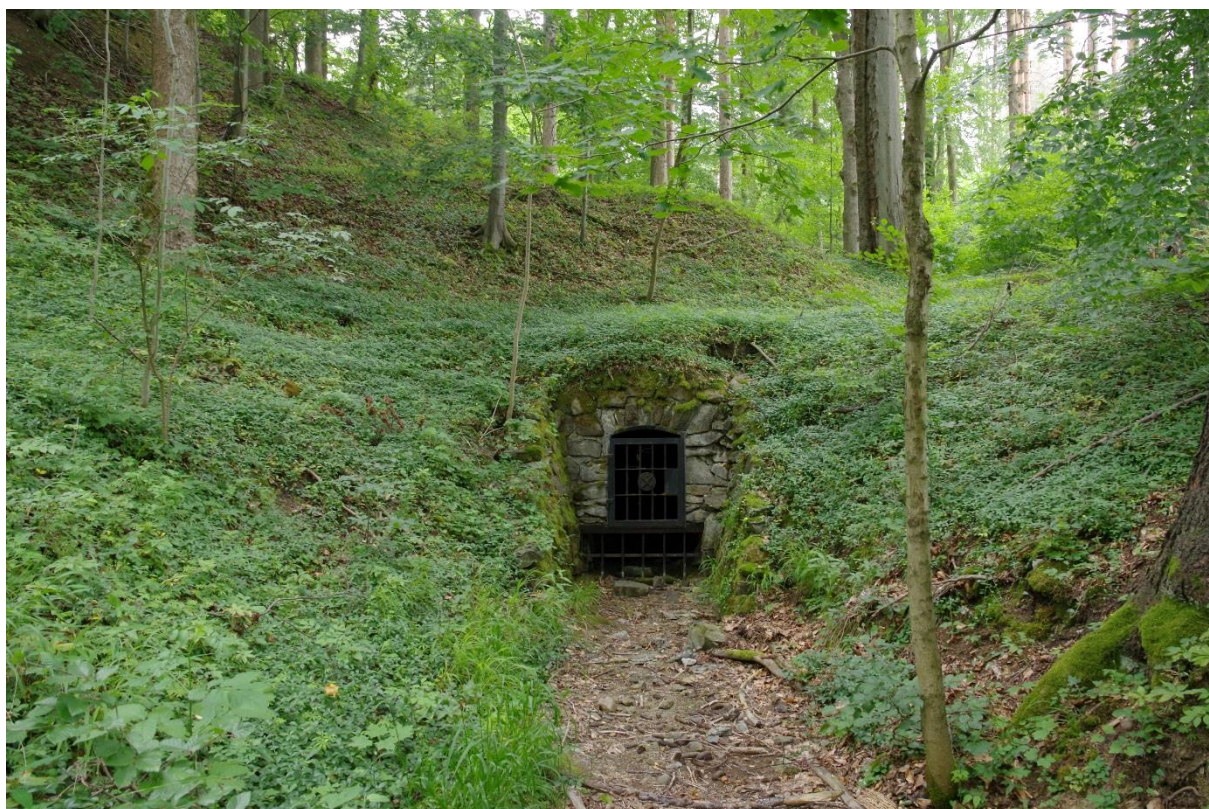
Obrázek 14: Vstup do štoly v jižní části PR je zajištěn mříží nejen z důvodu bezpečnosti, ale i za účelem ochrany významného zimoviště netopýrů.
