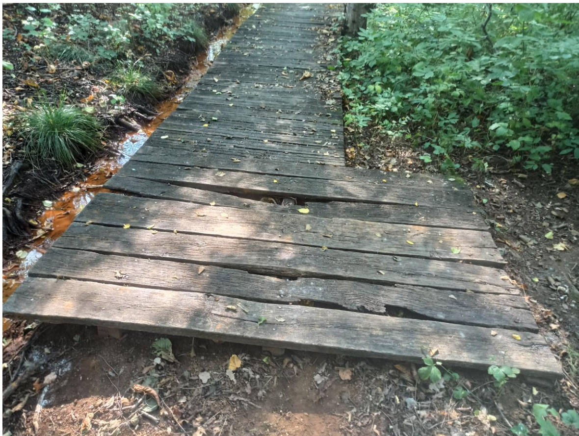
Obr. 4: povalový chodník v kritickém stavu
